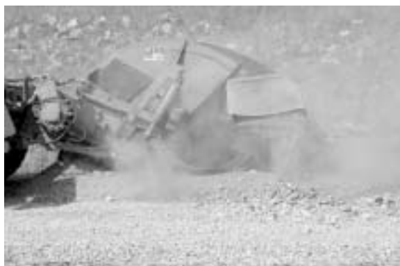
Fig. 12 - Particolare della fresa circolare utilizzata per la realizzazione del cavidotto durante l'esecuzione dello scavo.
