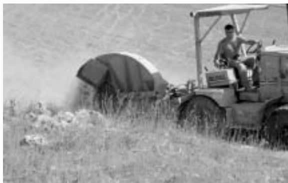
Fig. 11 - Fresa circolare utilizzata per la realizzazione dello scavo.
