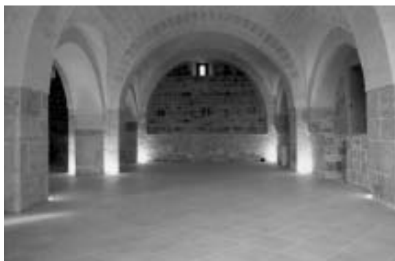
Fig. 7 - Masseria Ragone . Visione dell'interno dopo l'effettuazione dei lavori di restauro.
