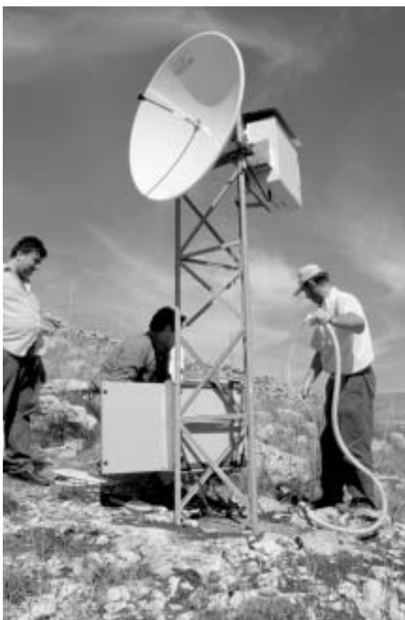
Fig. 16 - Sistemazione della parabola per il collegamento con ponte radio tra la collina di Lamalunga ed il Museo Archeologico di Altamura.
