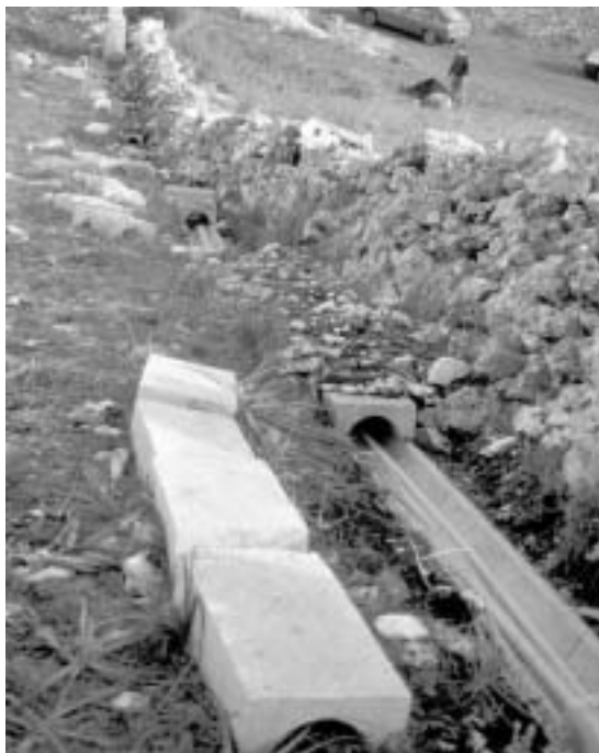
Fig. 8 - Cablatura della collina di Lamalunga nel tratto dall'ingresso della grotta fino alla lama sottostante.
